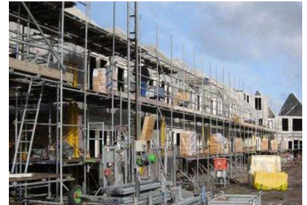
Steigerwerk aanbrengen
