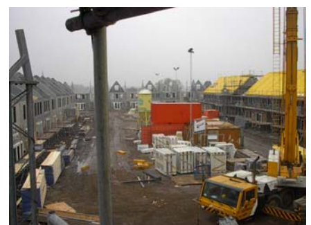
Overzicht bouwplaats maart 2009
