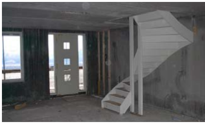
Trappen etc. plaatsen
